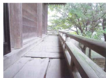
御神殿周囲を取り囲む「濡縁」(東側)欄干や、踏み板の傷みが激しい。
