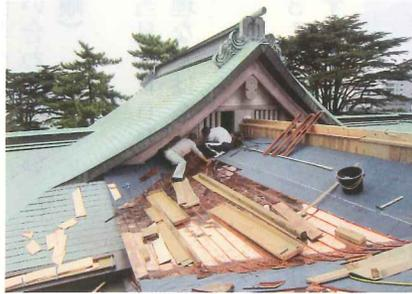
へお遷しました。昭和33年の再建当時の銅板を撤去し、雨漏り対策を施した御屋根葺替え工事が約二ヶ月間行われました。
